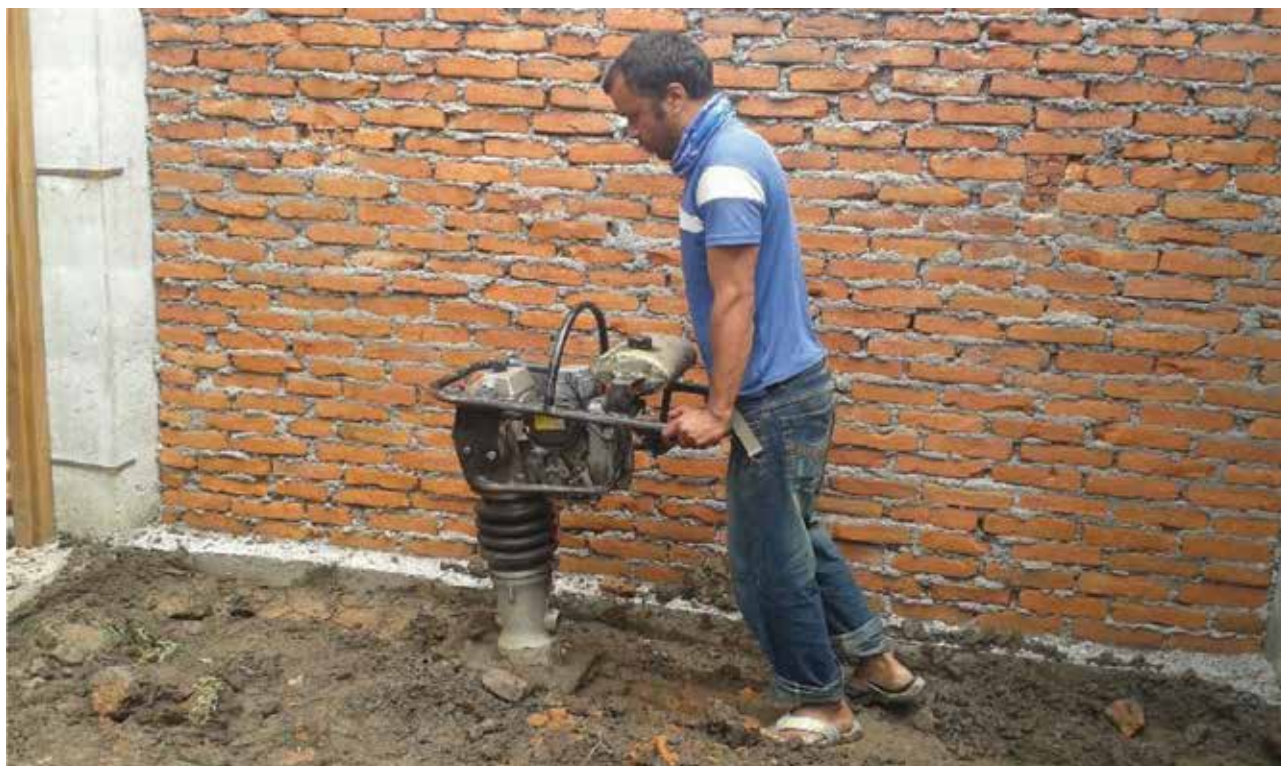
मेसिनबाट खाँदने काम भइरहेको
